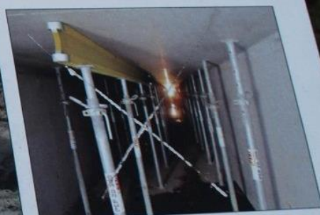
Constructie van de binnenzijde van de sifon
